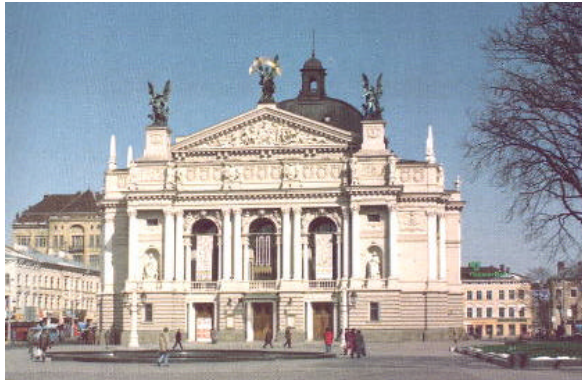
Det kjente opera/teater bygget i sentrum av Lviv.
